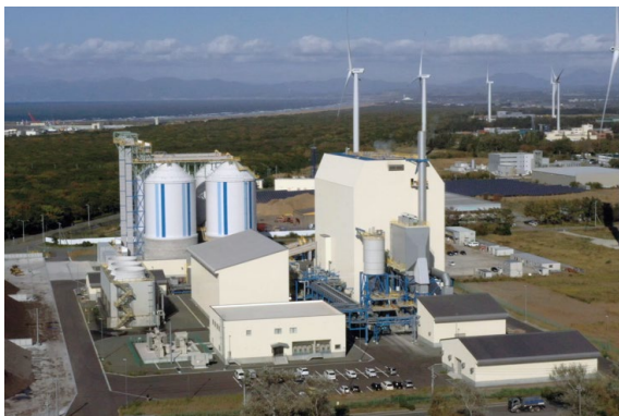
[写真：石狩新港バイオマス発電所]
