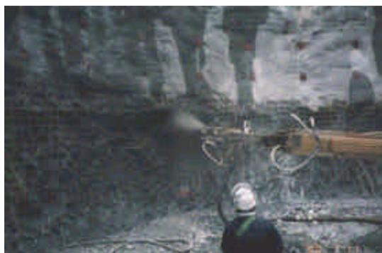
石炭灰を使用したコンクリートの吹き付け
