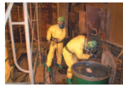
除染作業状況（セミウエット工法）
