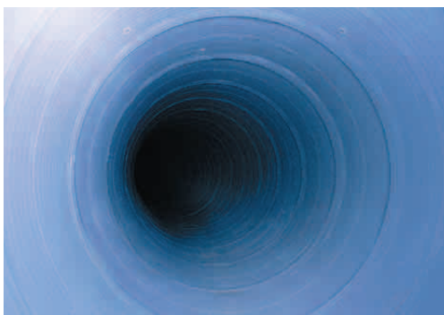
ポリリング工法による2次覆工(富田林シールド工事所)
