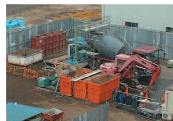
浸漬処理工法による実証試験状況
