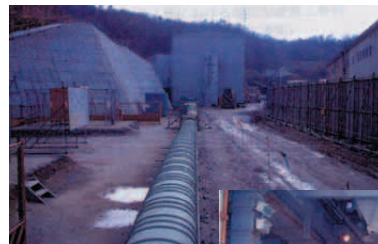
掘削土運搬用ベルトコンベア(騒音防止カバー付)
