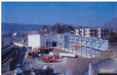
防音壁(高さ10m)と防音ハウス
