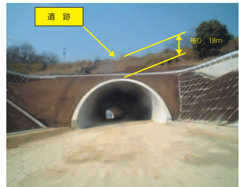
トンネル全景 (I期線完了時)
