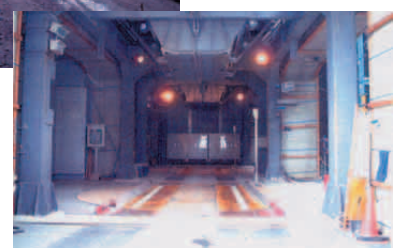
掘削土搬出車両の出入口(自動計量システムを採用したターンテーブル)
