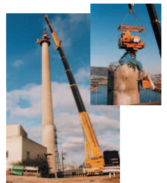
煙突解体ロボット（NOCC工法）
