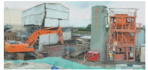
汚泥の現場内流動化処理（大里シールド工事所）
