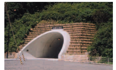
土地の草本類を用いた法面の緑化（平山トンネル工事所）
