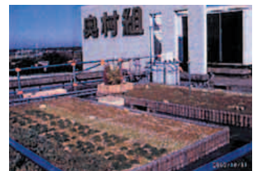
試験施工状況(奥村組技術研究所)
