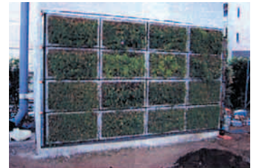
緑化パネル設置状況(垂直壁面実験工事)
