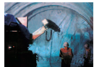
石炭灰利用吹付けコンクリートによる施工状況
