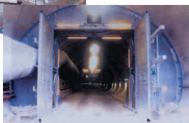
2重の防音扉(坑口)
