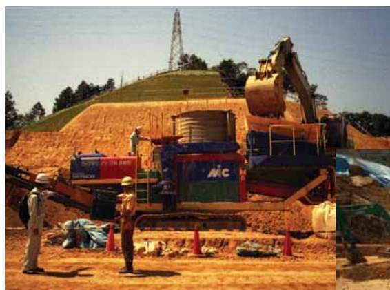
安定処理土製造状況
