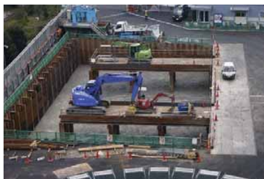
栈橋設置状況
