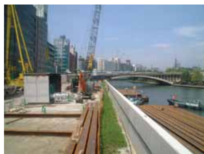
河川からの鋼材搬入
