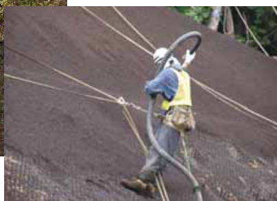
法面への吹付け状況
