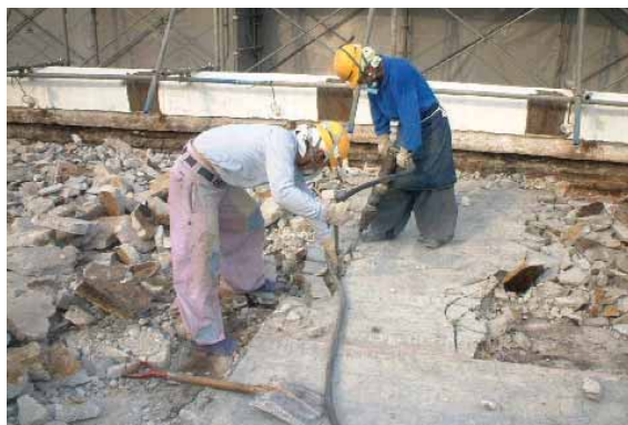
屋上シンダーコンクリート
