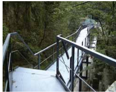
完成状況（上部構造）
