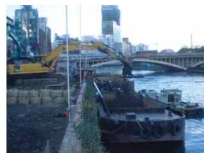
残土搬出状況
