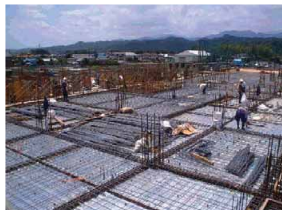
代替型枠の使用
