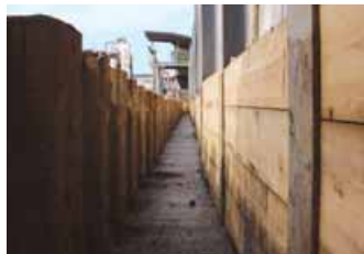
トレンチ設置状況
