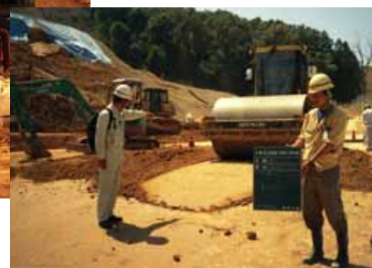
裏込め転圧状況
