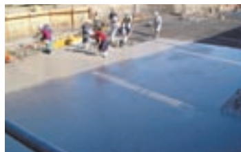
基礎打設状況
