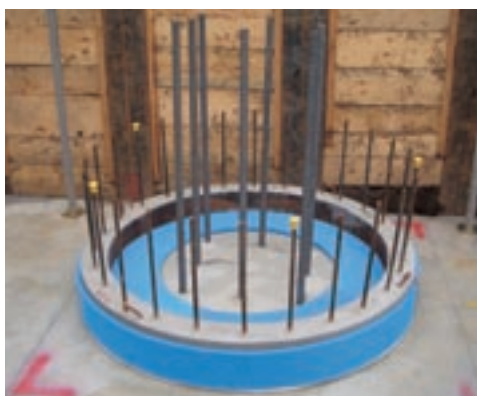
キャブテンパイル工法
