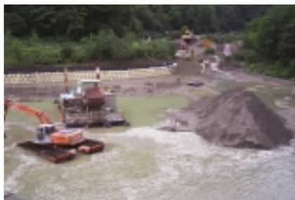
泥上掘削機と圧送船による浚渫作業
