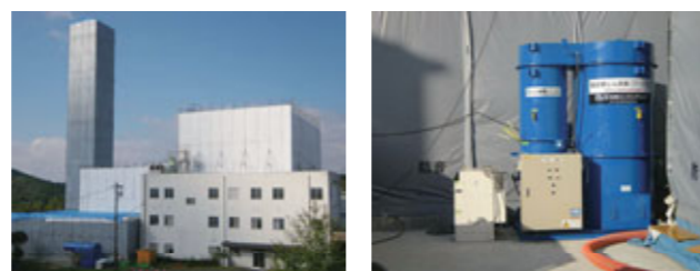
焼却施設のシート養生状況
