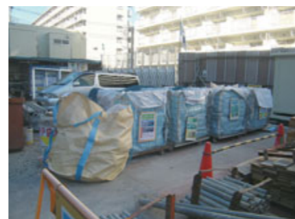
建設現場での廃棄物の分別
