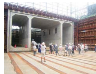
地元住民の現場見学会 (三重県 近鉄松阪工事事)
