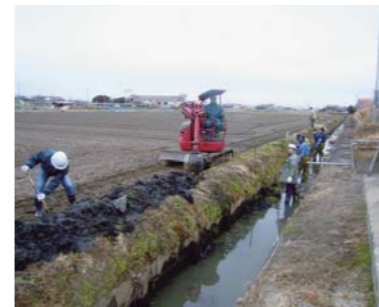
農業用水路のヘドロ除去(三重県 木曾川工事事)
