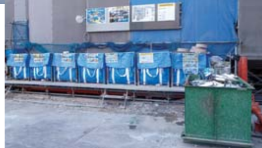
建設現場での廃棄物の分別
