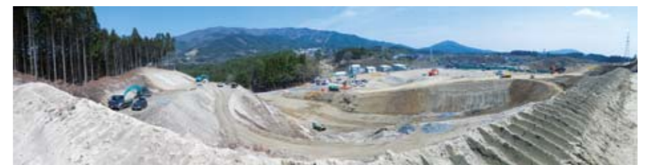
造成工事の状況（切土） 正面中央は市役所仮庁舎
