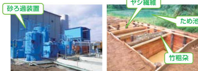
砂ろ過装置(30m 3 /h級)
