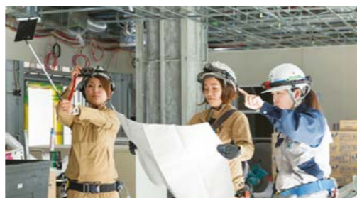
内装設備工事管理の様子
