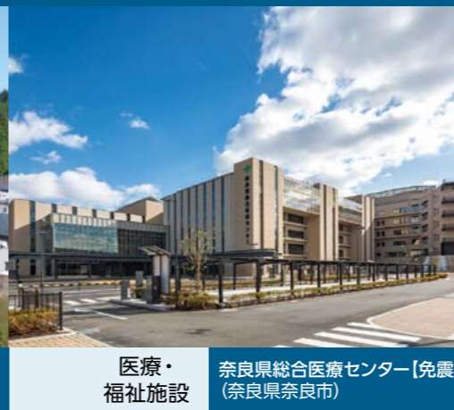
2017年度の主な完成工事[建築]
