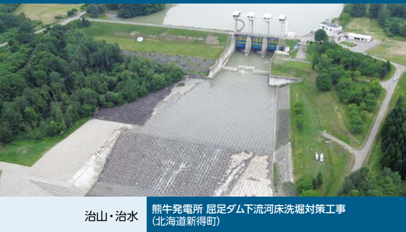
2017年度の主な完成工事[土木]
