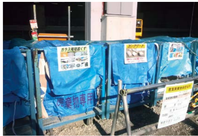
建設現場での分別
