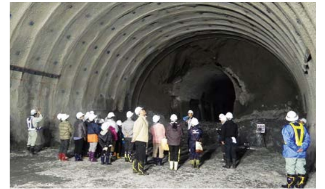
地元住民の現場見学会(岩手県 押角トンネル工事所)
