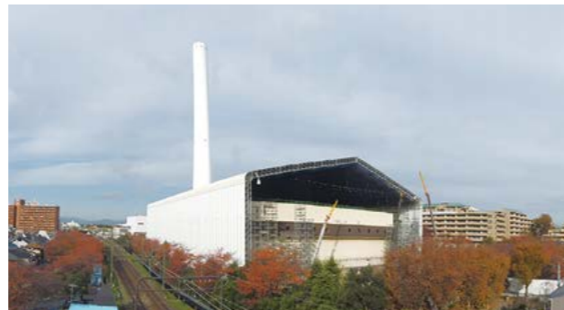
解体工事(仮設テントを設置)
