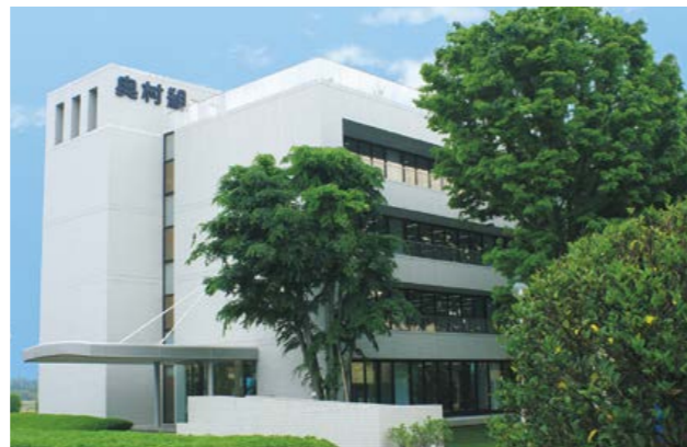
技術研究所管理棟
