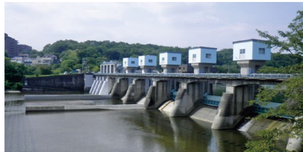
河川:矢作川総合第二期農地防災事業 明治用水頭首工耐震化対策建設工事(愛知県豊田市)
