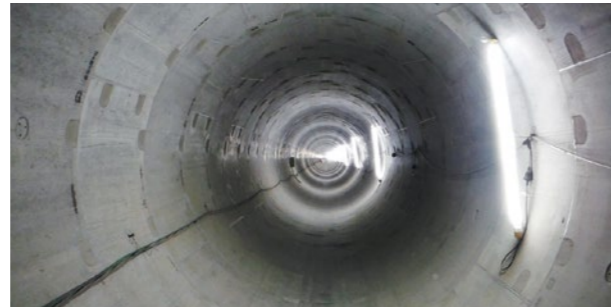
上・下水道:原町東部雨水幹線工事(宮城県仙台市)
