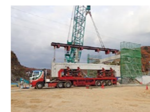
上部材の運搬専用トレーラー
