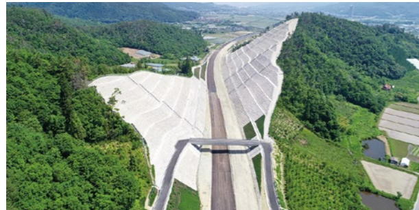
道路:東北中央自動車道 上山インターチェンジ工事(山形県上市市)
