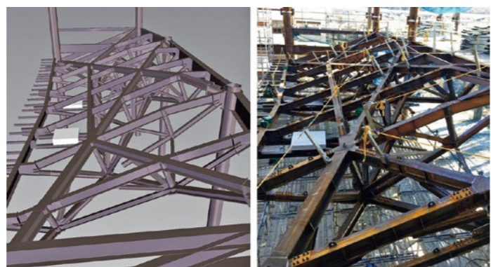
仕口や部材が複雑に交錯する立体トラスのBIMモデル(左)と工事所で組み立てられた部材(右)
