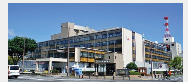
改修後の県庁舎
