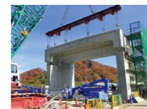
下部材と上部材の連結状況
