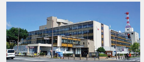
改修後の県庁舎
