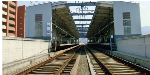
鉄道:奈良線八戸ノ里・福俣山間連続立体交差化工事に伴う 土木関係工事(大阪府東大阪市)
