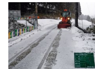
(青森県 深浦トンネル工事事)
