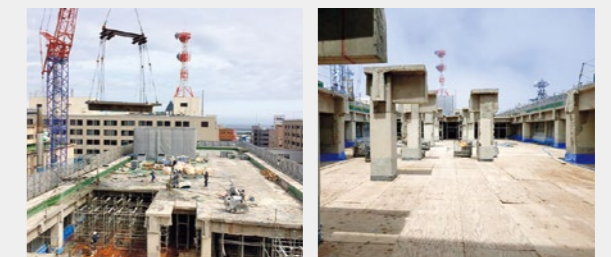
梁・床・撤去中の状況
