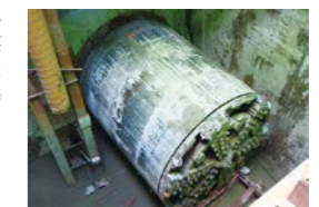
貫通後のシールド機
