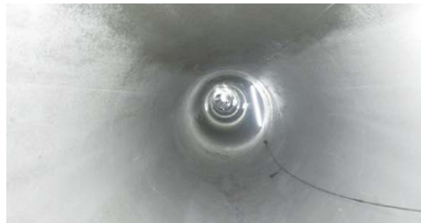
上・下水道: 新川第6排水区新川6号幹線(雨水)(その1)公共下水道工事(京都府京都市)
