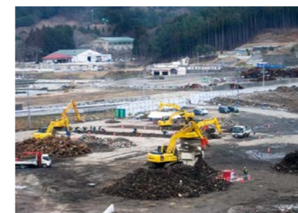
山田地区・機械および人力による廃棄物選別状況
