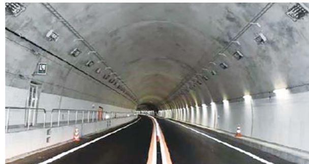
道路: 中部横断自動車道 石合トンネル工事 (山梨県南巨摩郡)
