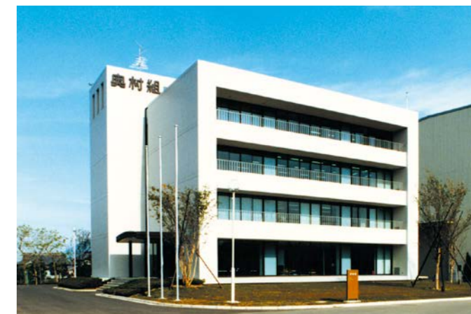
日本初の実用免震ビル 技術研究所管理棟
