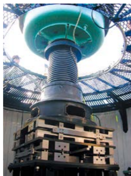
灯台レンズ用免震装置
