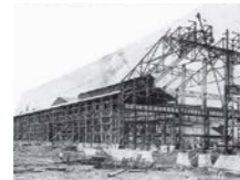
戸畑電接管工場新築工事
