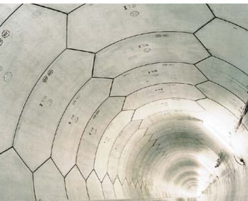
安威川流域下水道摂津高槻雨水汚水幹線
