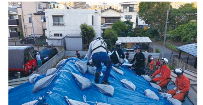
損壊した家屋屋根へのブルーシート敷設(千葉県内)
