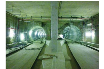
泥土圧シールド機8台を駆使して施工
