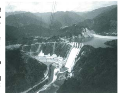
池原発電所全景
