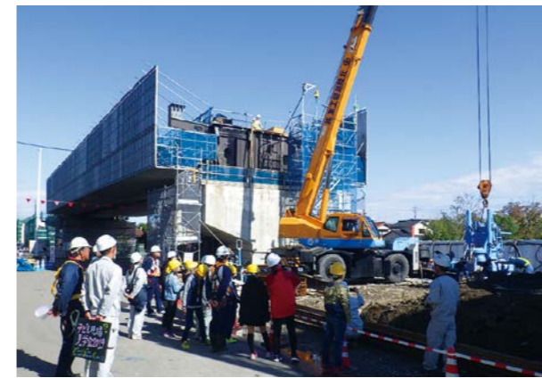
地元小学生を対象にした現場見学会(石川県 JRTT 小松駅高架 JV 工事所)
