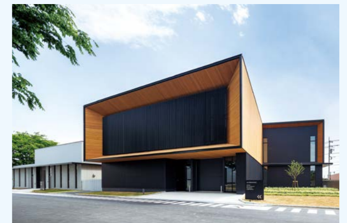
室内環境実験棟
