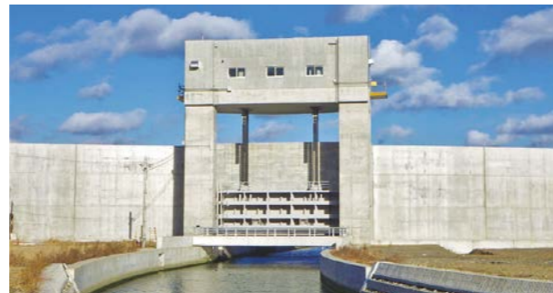
港湾・空港: 二級河川長部川筋長部川水門土木工事(岩手県陸前高田市)
