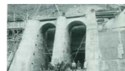
建設中の君田水力発電所取水口
