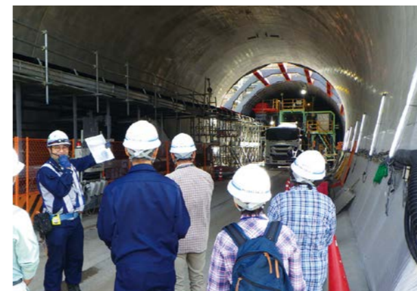
地域住民を対象にした現場見学会(北海道 羊蹄トンネル工事所)
