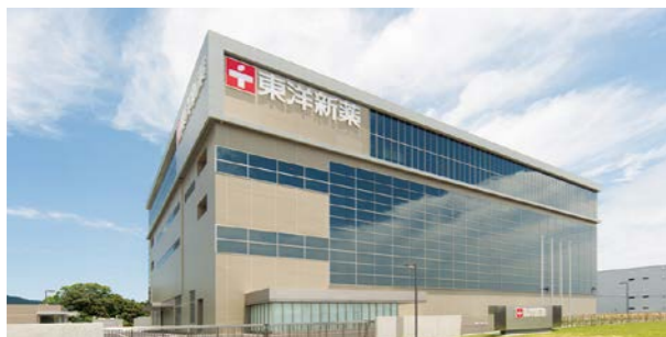
工場:東洋新薬 インテリジェンスパーク第一工場(佐賀県鳥栖市)
