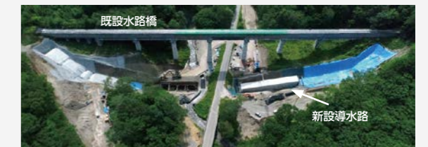
施工場所全景
