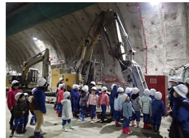
地元小学生を対象にした現場見学会(島根県 三隅岡トンネル工事所)
