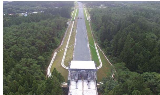
道路:国道45号 鹿糠地区道路改良工事(岩手県洋野町)
