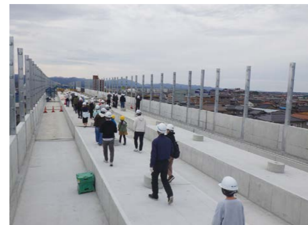
地域住民を対象にした現場見学会(石川県 JRTT小松駅高架JV工事所)
