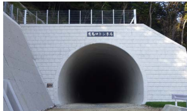
道路:(仮称)有馬口トンネル築造工事(兵庫県神戸市)
