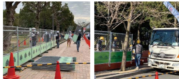
フェンス設置工事の様子
