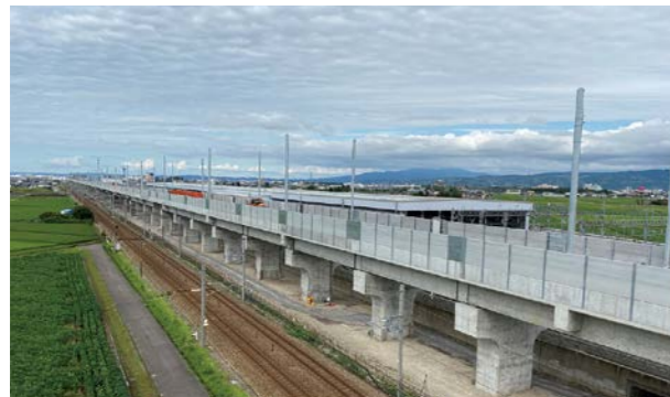
鉄道:北陸新幹線、白山宮保高架橋(石川県白山市)
