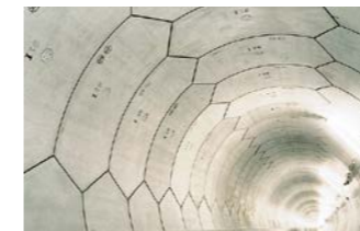
安威川流域下水道 摂津高槻 雨水汚水幹線
