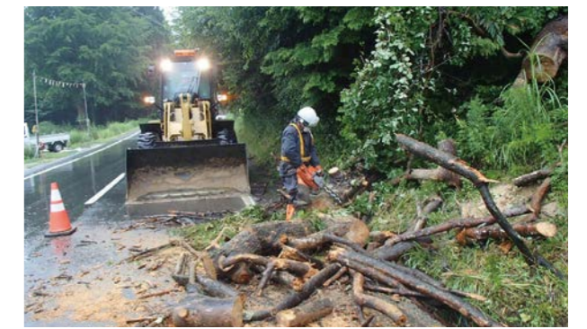
県道上の倒木撤去活動(福島県 葛尾村拠点除染工事所)
