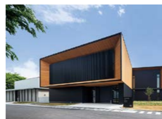
室内環境実験棟
