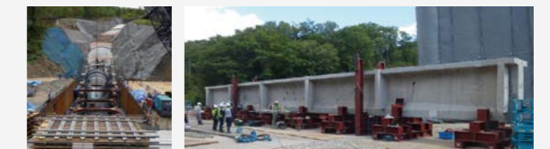
新設導水路(施工中)
