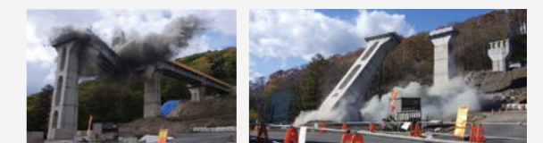
PC桁発破解体
