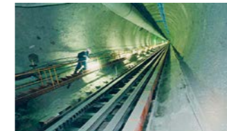
神流川発電所工事 の長大斜坑
