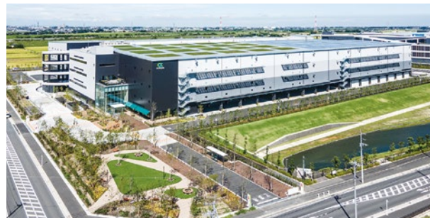
物流施設:GLP ALFALINK 流山8【免震】(千葉県流山市)
