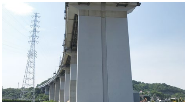
道路：番の州南高架橋耐震補強工事(香川県坂出市)
