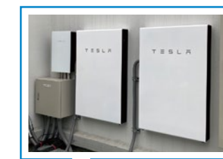
技術研究所管理棟に設置した蓄電池
