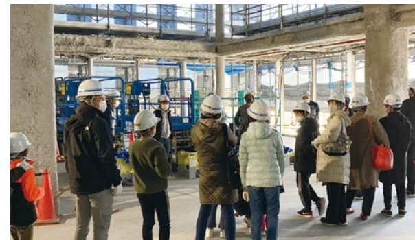
小学生を対象にした現場見学会(大阪府 貝塚市庁舎工事)
