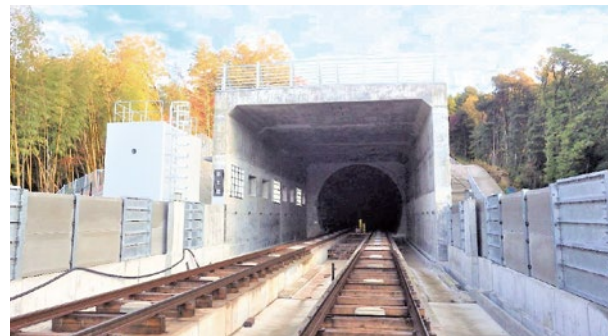
鉄道：北陸新幹線、新北陸トンネル(榎曲)他(福井県敦賀市)
