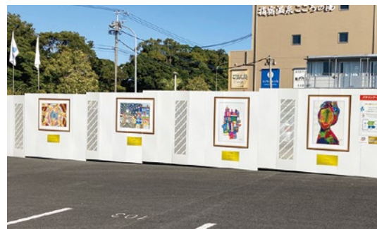
庁舎建設現場(鹿児島県)
