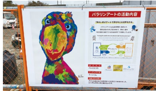
鉄道工事現場(宮城県)
