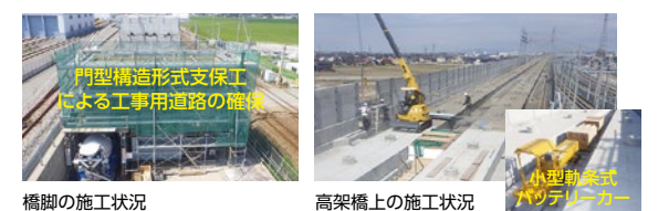
橋脚の施工状況
