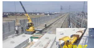
高架橋上の施工状況
