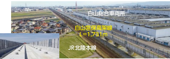
施工場所全景
