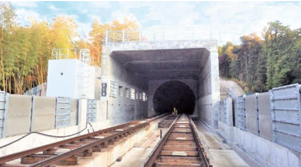
鉄道：北陸新幹線、新北陸トンネル(檜曲)他(福井県敦賀市)
