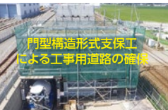
橋脚の施工状況
