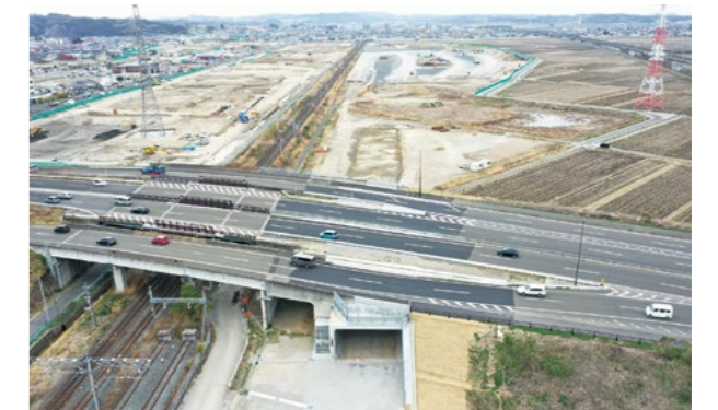
鉄道: 仙台貨物ターミナル駅移転に伴う函渠新設工事(仙台市宮城野区)
