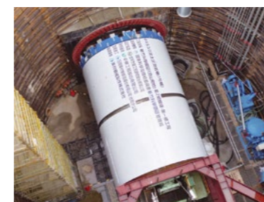
発進直前のシールド機
