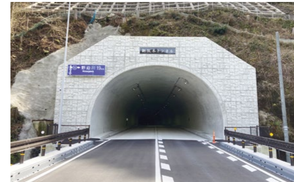
道路: 一般国道168号 阪本工区(仮称) 阪本トンネル工事(奈良県五條市)
