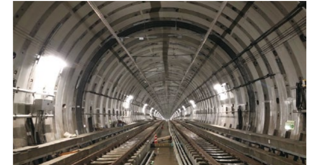
鉄道: 相鉄・東急直通線、新横浜トンネル(横浜市港北区)
