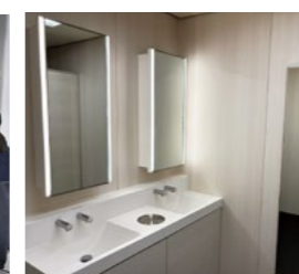
職場環境の改善例(女子トイレの改修)
