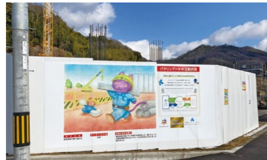
病院建設現場(広島県)
