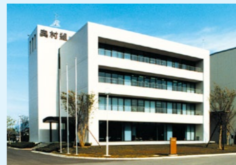
日本初の実用免震ビル 技術研究所管理棟
