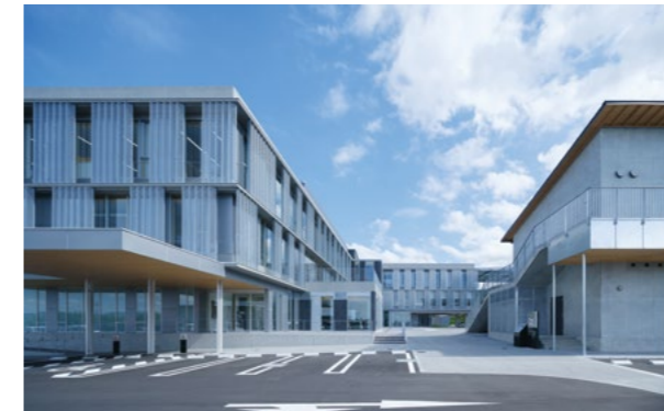
事務所・庁舎：井手町庁舎【免震】（京都府井手町）
