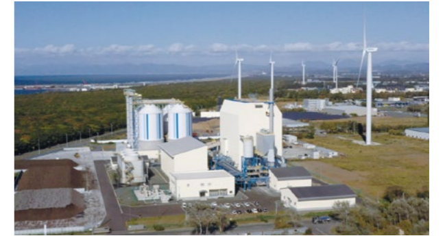
再生可能エネルギー事業:石狩バイオマス発電事業(北海道石狩市)
