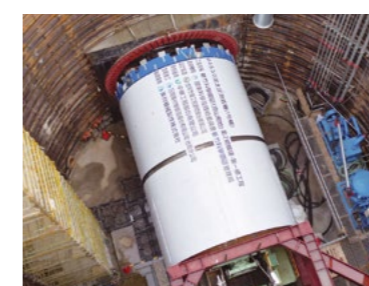
発進直前のシールド機
