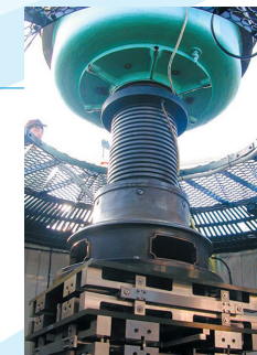
灯台レンズ用免震装置
