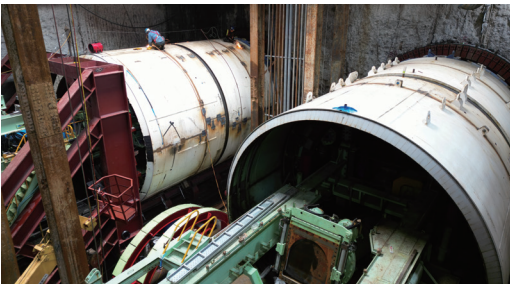
シールドマシン組立の様子
