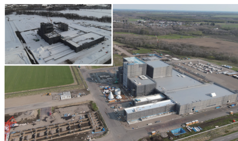
施工状況(2025年5月) (左上)冬季施工状況
