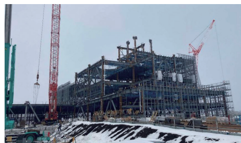
鉄骨建て方状況
