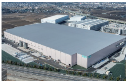
物流施設:ニトリ幸手DC(埼玉県幸手市)
