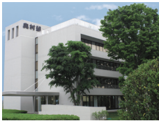
技術研究所管理棟
