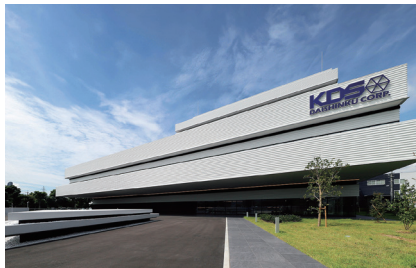
事務所・工場:大真空本社工場棟(兵庫県加古川市)
