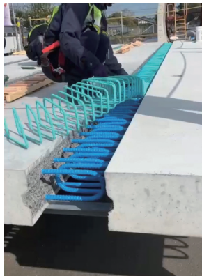
施工性確認試験の実施状況
