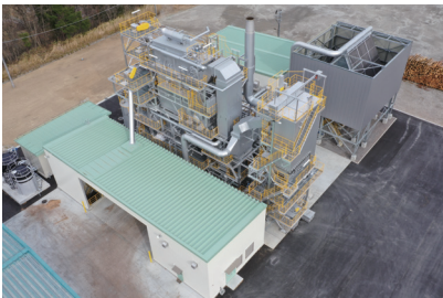
福島平田村バイオマスパワー2号機
