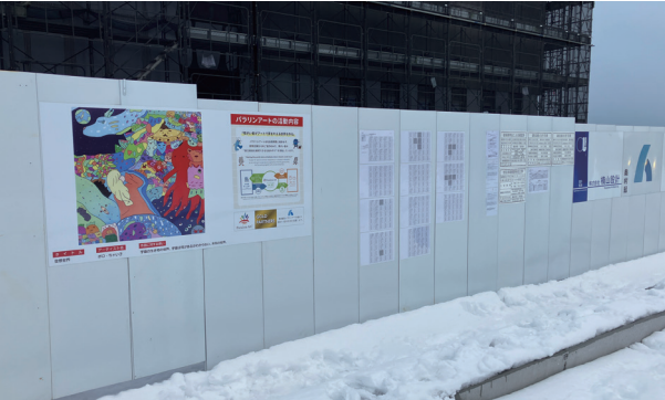
庁舎建設現場(青森県)
