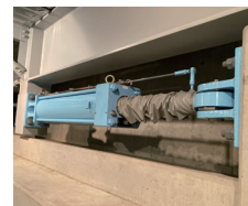
VOD®の設置状況
