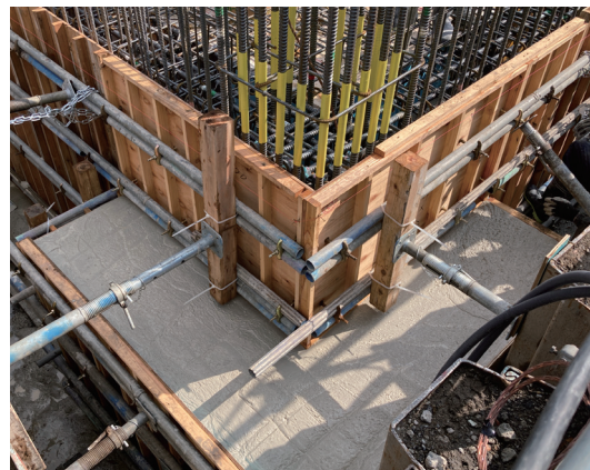
基礎・地中梁コンクリート打設状況
