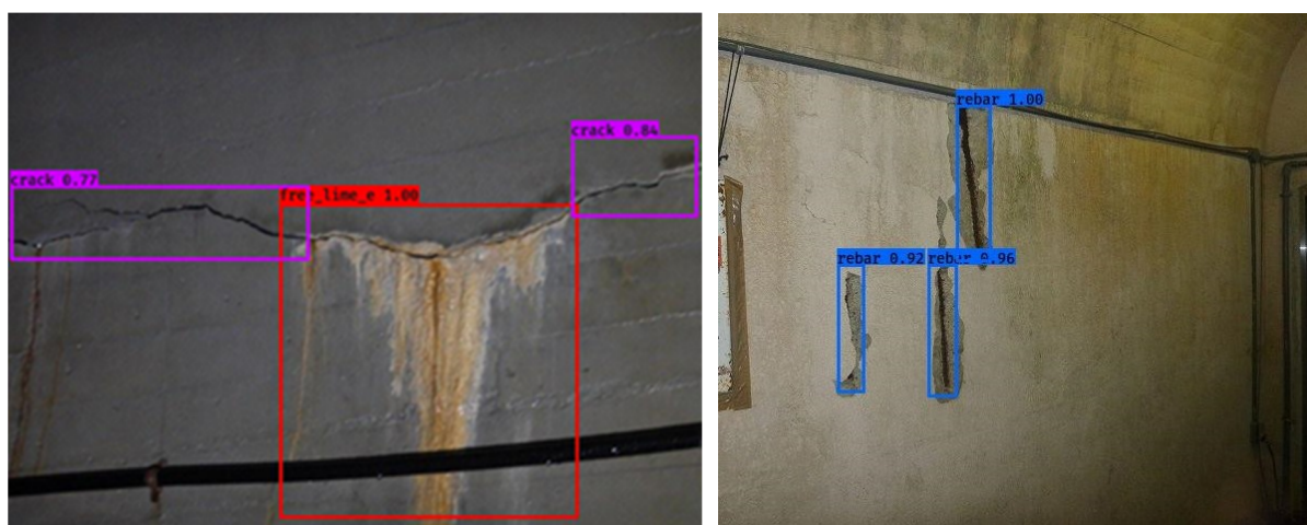
図-2 コンクリートのひび割れ、遊離石灰および鉄筋露出（AIによって正しく検出された例）
