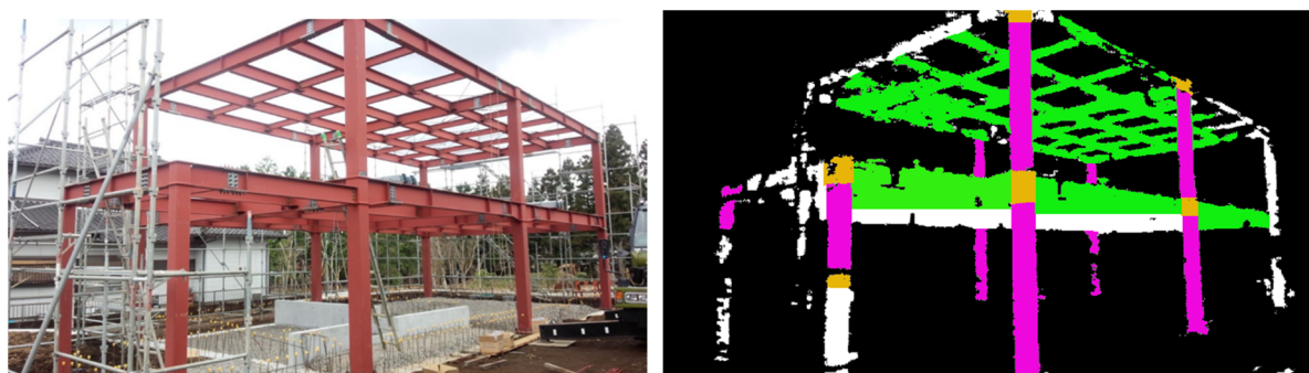
図-3 建築物の鉄骨建て方工事現場の写真およびAIによって梁（緑）、柱（ピンク）、接合部（オレンジ）が認識され色分けされた画像
