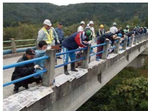
▲住民と学生との協働による橋の欄干塗装
