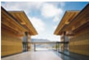
外観(渡り廊下部)
