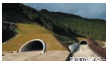
▲ 第二東名高速道路 金谷トンネル東(その4)工事 (静岡県島田市)
