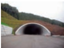
第二東名高速道路金谷トンネル
