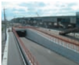
◀ 第二京阪道路高宮工事 (大阪府寝屋川市)
