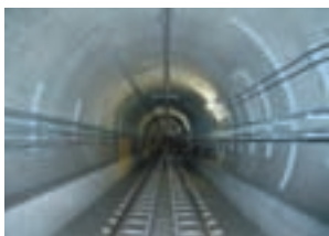
▶ 高速鉄道4号線城山工区 土木工事 (横浜市都筑区)
