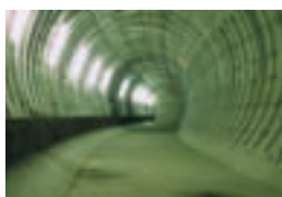
トンネル全景
