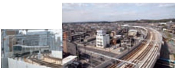
▲ 奈良高架大宮地区BL新設他1工事 (奈良市)
