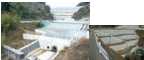
▲ 市道油木町西町線道路改良工事 (長崎市)
