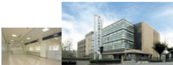
▲さいたま第2法務総合庁舎(さいたま市中央区)
