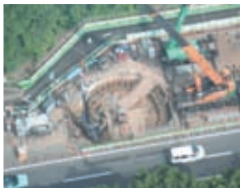
施工状況(上空より)
