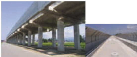
▲北陸新幹線、滑川中塚高架橋(富山県滑川市)
