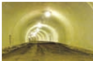
▲42号紀宝BP 紀宝トンネル工事 （三重県紀宝町）
