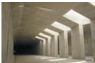
▲ 北国分地区函渠工事 (千葉県市川市)
