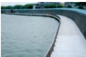
▲ 中川護岸耐震補強工事 (その13) (東京都葛飾区)
