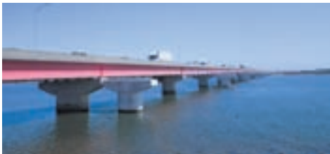
▲23号豊橋BP豊川橋右岸下部工事（愛知県豊橋市）
