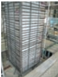
試験体巻立状況
