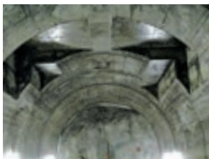
複雑な断面での充填状況(避難連絡トンネルの非常扉取付部)
