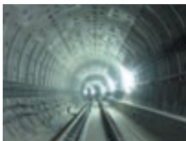
▲ 台北地下鉄空港線 CU02A工事 (中華民国・台湾桃園縣)
