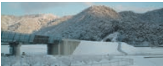
▲ 舞鶴若狭自動車道 田上トンネル工事 (福井県若狭町)
