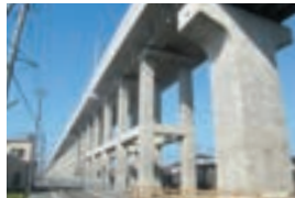
▲ 北陸新幹線、 金沢八日市高架橋 (石川県金沢市)
