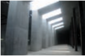
◀ 田尻地区函渠工事 (千葉県市川市)
