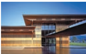
外観(渡り廊下部)
