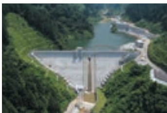
▲ 舟川総合開発事業 舟川ダム本体工事 (富山県入善町)
