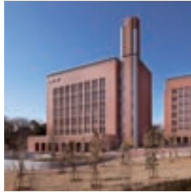
▲ 大和大学管理棟 (大阪府吹田市)
