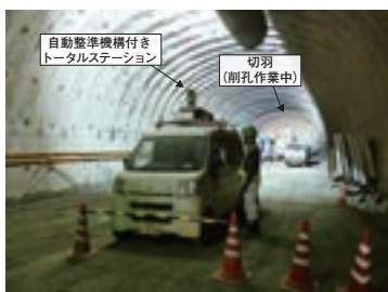
本システムによる計測状況
