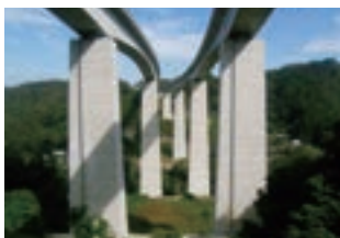
▲ 関越自動車道 永井川橋耐震補強工事 (群馬県渋川市～みなかみ町)
