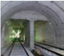
▲ 仙台市地下鉄東西線 亀岡トンネル他 (宮城県仙台市)
