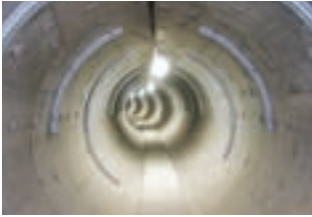
▲ 飯倉芝公園管路新設工事 (東京都港区)
