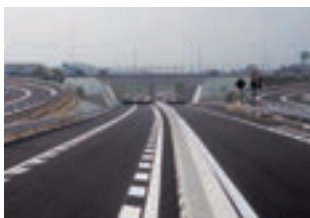
▲ 九州自動車道嘉島工事 (熊本県嘉島町～益城町)
