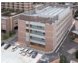
▲ 九州厚生年金病院別館、 駐車場棟 (福岡県北九州市)
