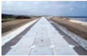
▲ 仙台湾南部海岸中浜工区 坂元地区第2復旧工事 (宮城県山元町)
