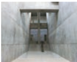
▲ 小野浜ポンプ場 築造工事 (兵庫県神戸市)
