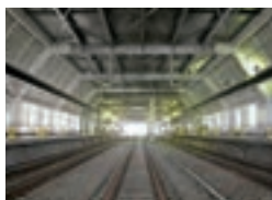
▲ 北海道新幹線 奥津軽いまべつ駅構内、 奥津軽路盤他工事 (青森県今別町)
