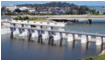
▲梯川逆水門耐震補強外工事 (石川県小松市~白山市)
