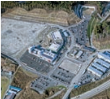
▲高田西地区復興整備造成工事 (岩手県陸前高田市)
