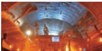
天井板中央部の縦断切断状況
