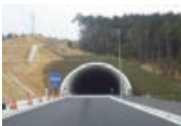
▲ 国道11号大内白鳥バイパス 前山トンネル工事 (香川県東かがわ市)
