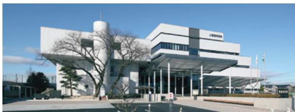
▲愛西市役所(愛知県愛西市)
