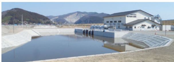
▲中津山農業水利事業後谷地排水機場建設工事(宮城県石巻市)
