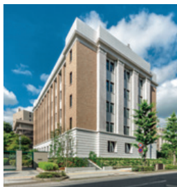
▲滋賀県危機管理センター(滋賀県大津市)
