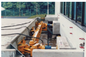
建物を強制的に水平移動させるジャッキの設置状況
