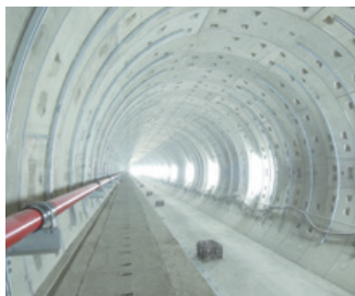
▲台北地下鉄環状線CF643A標シールド工事(中華民国台湾・台北市)
