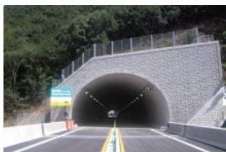
▲那智勝浦道路湯川第二トンネル工事(和歌山県那智勝浦町)
