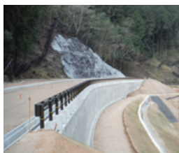
▲大津信楽線左岸部道路整備工事(滋賀県大津市)
