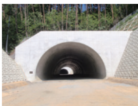
▲国道45号磯の沢地区トンネル 工事(宮城県南三陸町)
