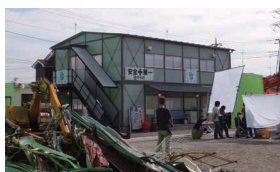
工事所を再現したセット (外観)
