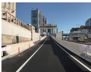
▲(修)臨海副都心出口基礎・擁壁 その他工事 (東京都江東区青海～品川区八潮)
