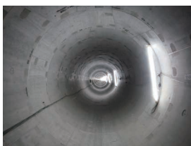
▲原町東部雨水幹線工事1 (宮城県仙台市)
