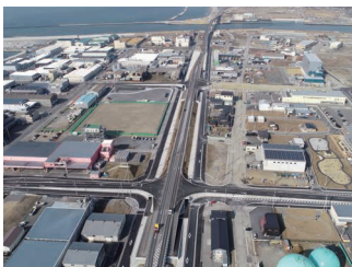
▲ 魚町道路改築工事 (宮城県石巻市)
