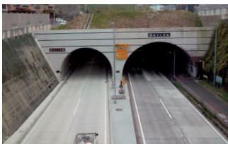
▲ 休山改良休山トンネル長迫工事 (広島県呉市～和庄町)
