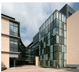
▲キセラ川西プラザ (兵庫県川西市)
