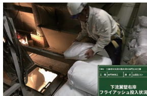
フライアッシュ投入状況
