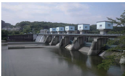
▲ 矢作川総合第二期農地防災事業 明治用水頭首工耐震化対策建設工事 (愛知県豊田市)
