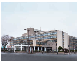
▲ 青森県庁舎 【耐震・長寿命化改修工事】 (青森県青森市)
