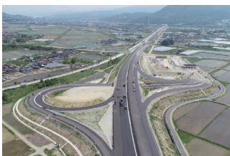
▲ 東北中央自動車道 上山インターチェンジ工事 (山形県上市市小穴～関根)
