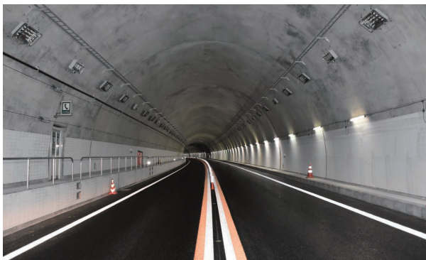
中部横断自動車道石合トンネル工事 (山梨県南部町)
