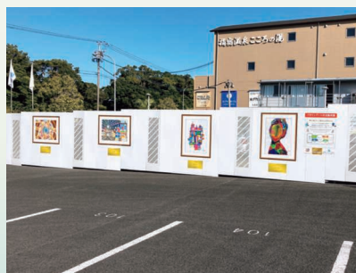
庁舎建設現場(鹿児島県)
