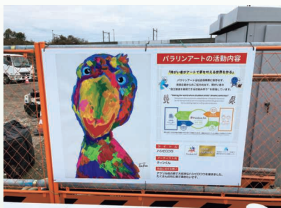
鉄道工事現場(宮城県)
