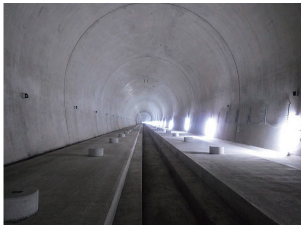
北陸新幹線、新北陸トンネル(樫曲)他 (福井県敦賀市)
