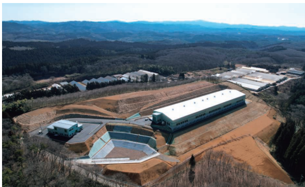
共同一般廃棄物最終処分場建設工事 (栃木県那須町)
