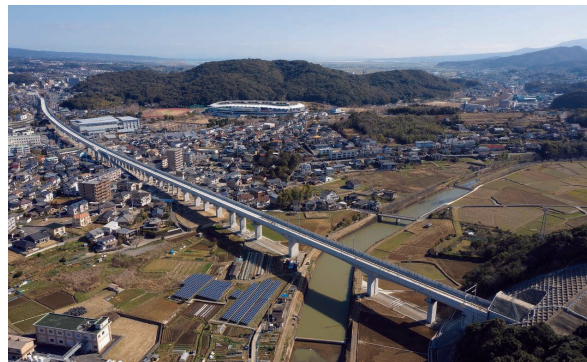
九州新幹線(西九州)、平山高架橋 (長崎県諫早市)
