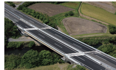
令和4年度 宮崎自動車道(特定更新等) 陣之原橋(上り線)他1橋床版取替工事 (宮崎県えびの市)
