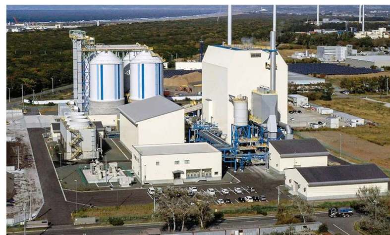
【石狩新港バイオマス発電所(北海道石狩市)】
