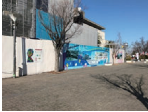
⑫庁舎建設現場（大阪府）
