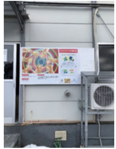
③トンネル工事現場事務所（北海道）
