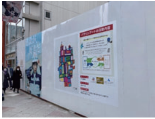
⑩マンション建設現場（東京都）
