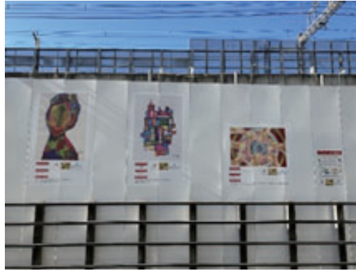
⑫鉄道工事現場（東京都）
