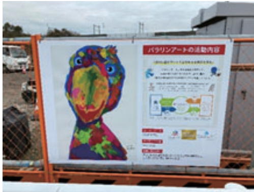
⑤鉄道工事現場（宮城県）
