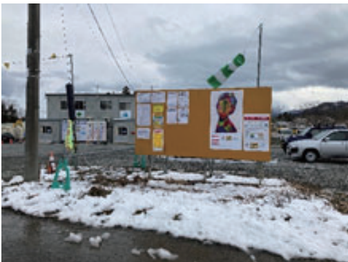
⑥造成工事現場（福島県）
