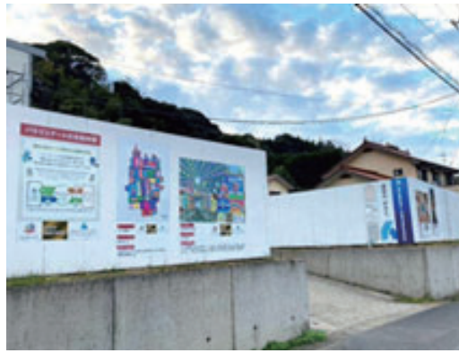
②③トンネル工事現場（島根県）
