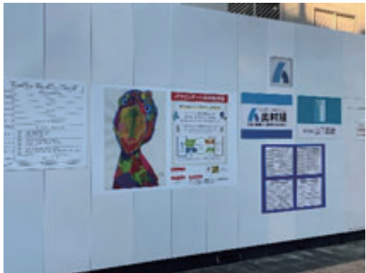
⑬庁舎建設現場（大阪府）
