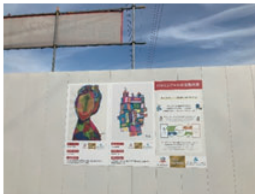
⑮庁舎建設現場（愛知県）
