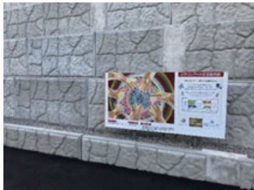
②⑤高速道路工事現場（香川県）
