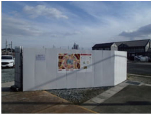
⑩鉄道工事現場（愛知県）
