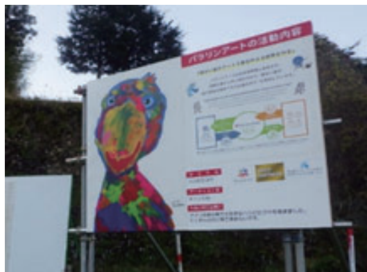
②⑦トンネル工事現場（長崎県）
