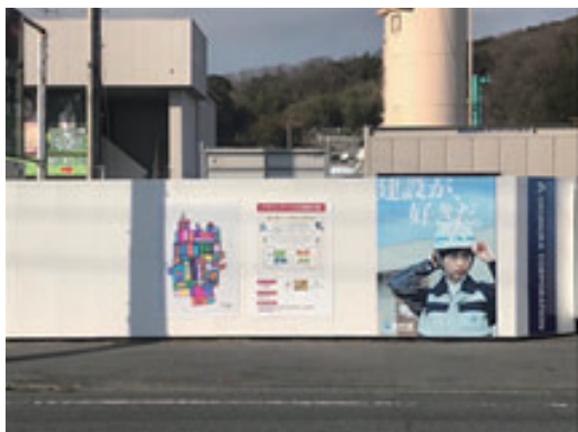
⑭病院建設現場（岡山県）
