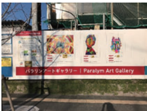
②⑧庁舎建設現場（鹿児島県）
