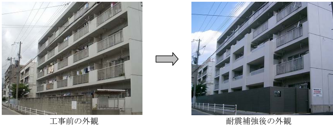
写真-1 バルコニー付き建物の耐震補強工事状況(5階建て建物の施工例)
