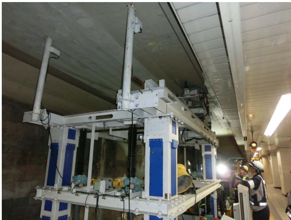
写真-3 研掃装置による施工状況
