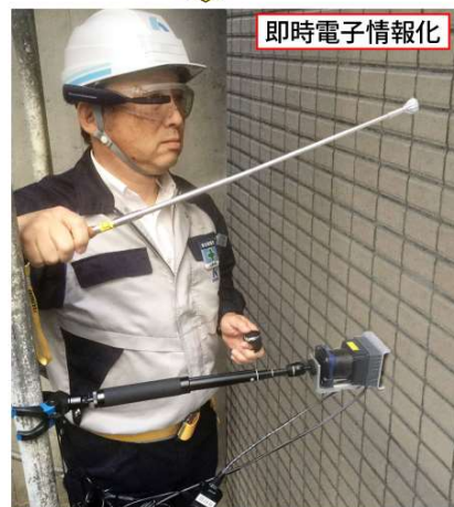
写真2 打診調査作業状況(イメージ)
