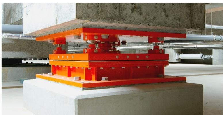
写真－2 微振動対策ダンパー外観
