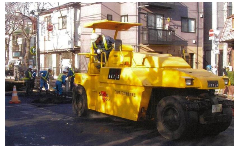
道路工事中の作業員後方から、ローラー等がバックで接近した事を、重機後部に取り付けた「みはりセンサー」と作業員のヘルメット後頭部に取り付けた「ヘルセンサー」で感知し、音と振動で作業員と運転席に危険を知らせる警報補助装置です。
