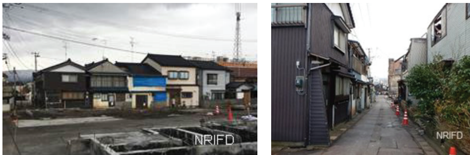
写真 糸魚川市大規模火災で延焼が止められた木造住宅の一角
