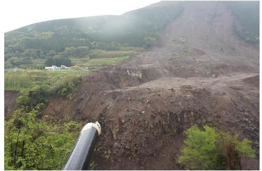
南阿蘇村：阿蘇大橋の落橋
