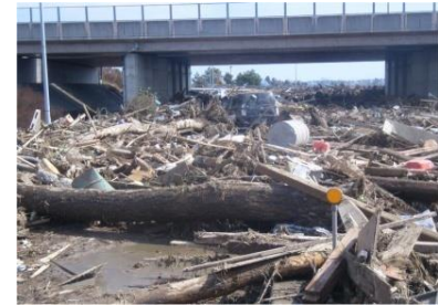
東日本大震災の津波被災状況
