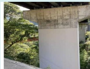
高知自動車道(新宮~大豊)久保ヶ内橋
