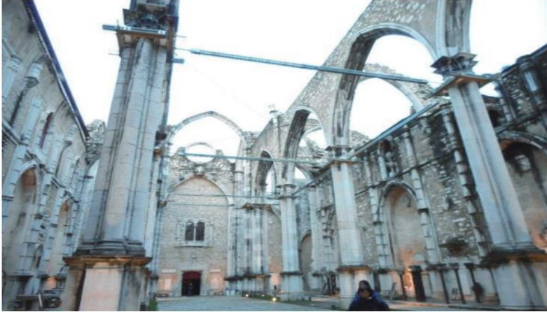
リスボン大地震によって倒壊したカルモ教会 引用:公財ひょうご震災記念21世紀研究機構「リスボン地震とその文明的意義の考察」
