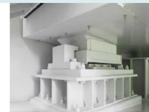
大分自動車道(湯布院~日出)福万川橋
