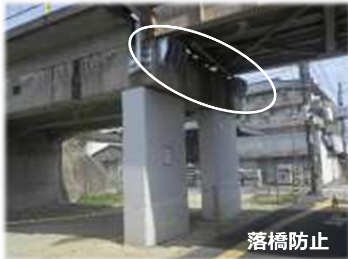
高架橋柱（せん断破壊先行型）
