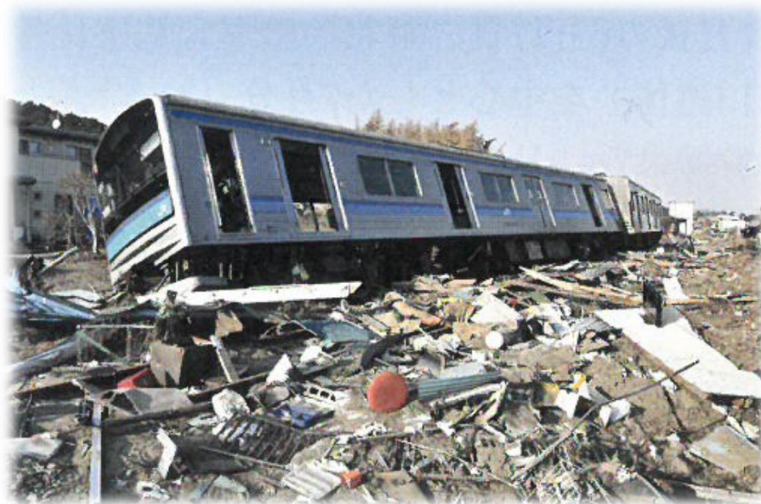
津波による車両・線路設備等の流出 (仙石線 野蒜 (のびる) 駅)
