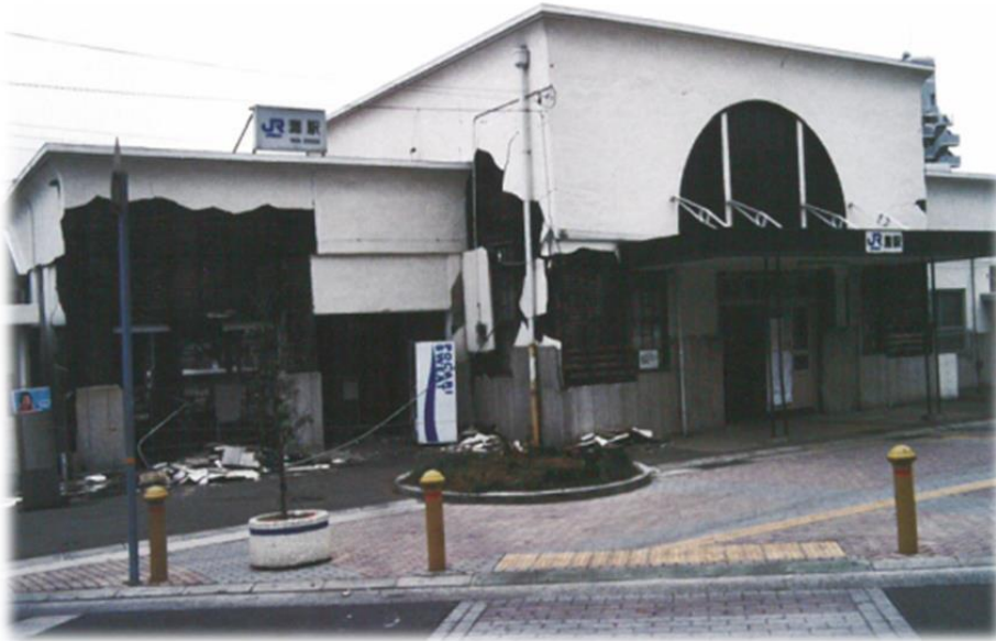
木造駅舎の損傷 (東海道線 灘駅)
