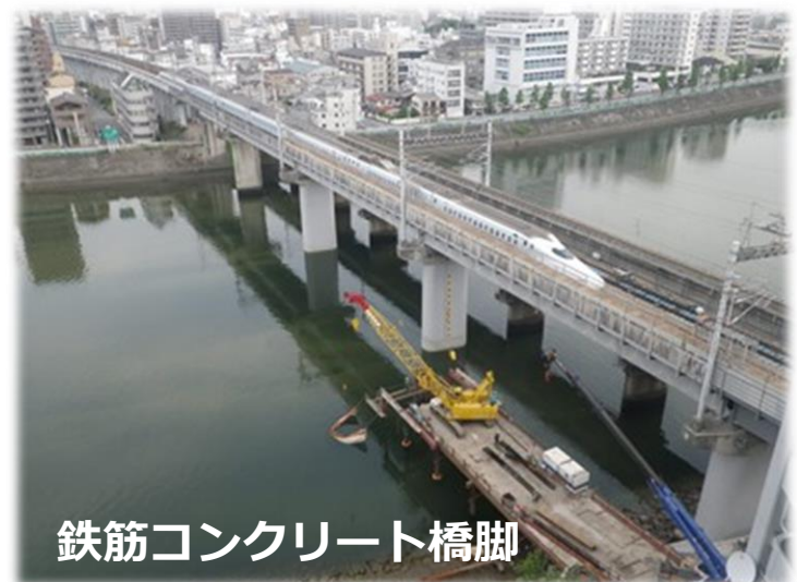
高架橋柱（せん断破壊先行型）
