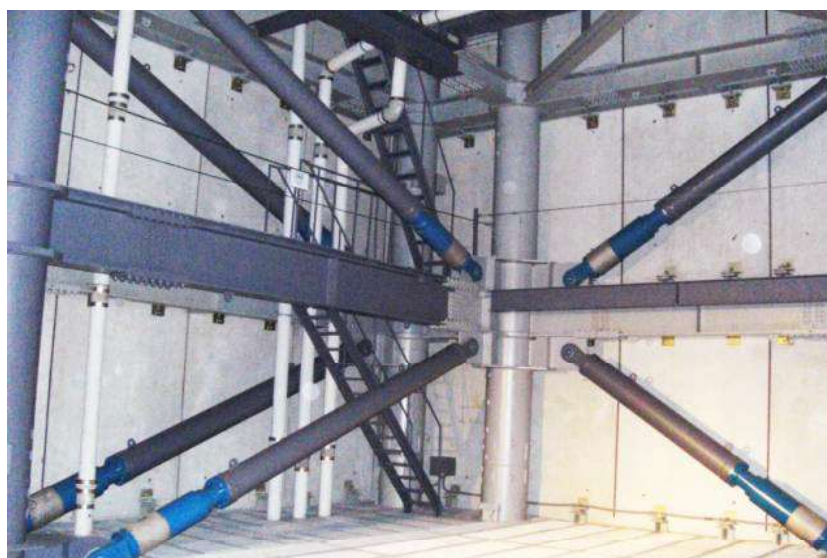
制振ブレースの設置状況（竣工）
