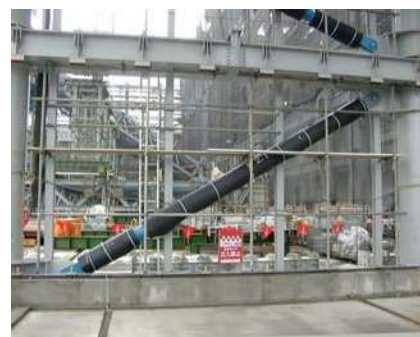
制振ブレースの工事状況
