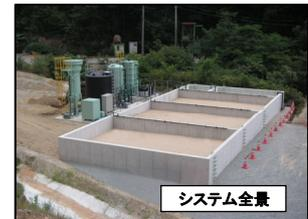
≪設備の逆洗浄時に発生する汚泥は、天日乾燥床で乾燥させ産廃処分します。≫
