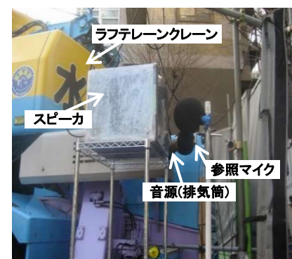
写真-2 ラフテレーンクレーンへの適用
