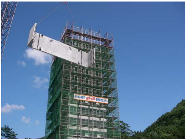
3Hパネルの吊りこみ
