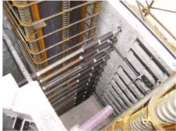
3Hパネルと帯鉄筋の連結
